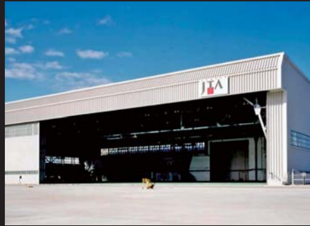
日本トランスオーシャン航空 那覇空港格納庫 JTA Naha Airport Hangar
