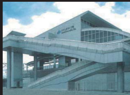
JR ささしまライブ橋上駅 Sasashima-raibu Station
