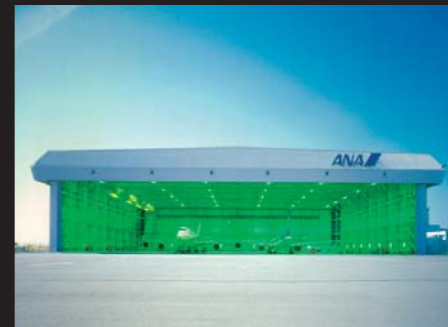
全日本空輸 関西国際空港 関西第1号格納庫 ANA Kansai International Airport Hangar No.1
